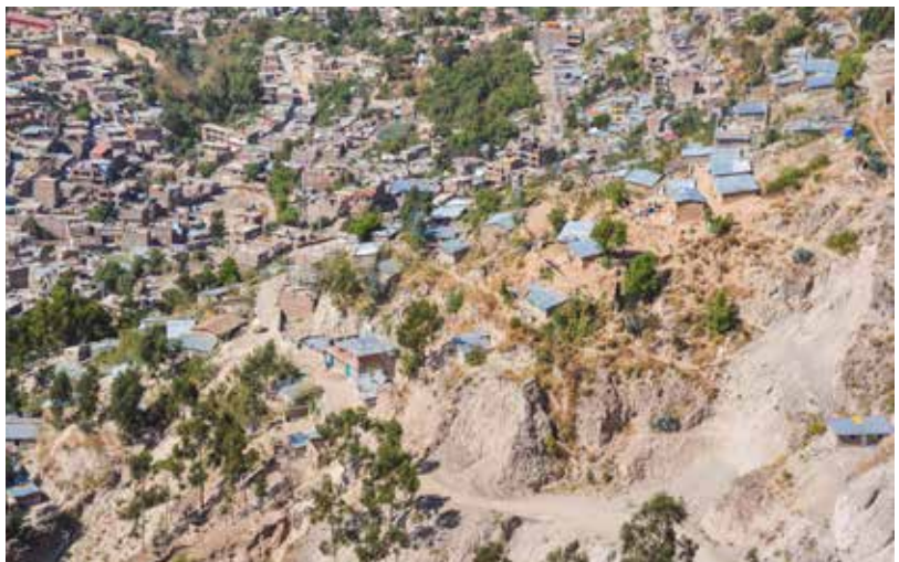
► Urbanización en las laderas y zonas de riesgo
